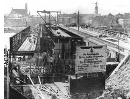
Bau der Nibelungenbrücke, 1940
